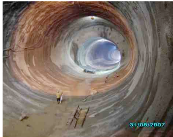
Figura 17 – Seção Plena – Vista do Corpo da Estação (lado Higienópolis) após conclusão da escavação
