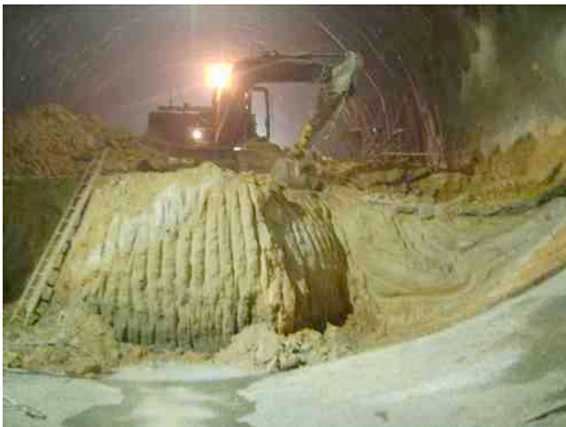
Figura 16 – Fase de escavação do AID – Detalhe da escavação do nicho lateral
