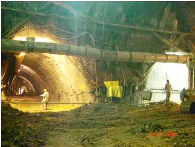
Figura 14 – Fase de escavação dos side drifts – Vista do Túnel de Ligação para o lado Oscar Freire.
